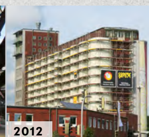
AGRAVIS AG Münster Besondere Anforderungen erfordert die Einrüstung runder Objekte – wie an diesem Silotrichter am Kraftfutterwerk.
