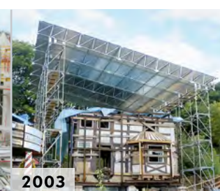
Wetterschutzdach Detmold Für Umbauten und Instandsetzungsarbeiten, wie hier an einem historischen Baudenkmal, können Wetterschutzdächer erbaut werden.
