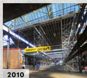
Eisenbahnausbesserungswerk Lingen Ein fahrbares Raumgerüst konnte mit den Sanierungsarbeiten an den Dachflächen mitwandern.
