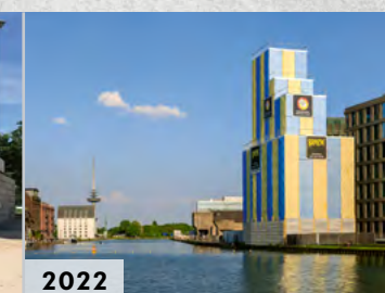
Hafenkran Münster Spezialgerüstkonstruktion für Sanierungsarbeiten am ehemaligen Kohlekran am Südkai.
