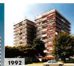
Mehrfamilienhaus Münster Das perfekte Zusammenspiel mit den Malerbetrieben zeigt sich besonders im Bereich der klassischen Fassadengerüste.
