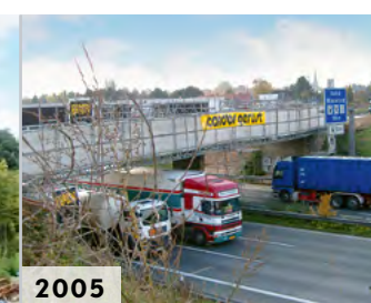
Brücke A1 Bei Hängegerüsten sind Sicherheit und minimale Verkehrsbehinderung das Wichtigste.
