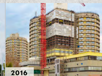
Universitätsklinikum Münster Das Gerüst mit Schallschutzwänden an den Bettentürmen fußt auf einer Extra-Konstruktion aus Stahlträgern auf 20 m Höhe.
