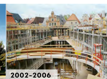
Arkaden Münster Auf der Großbaustelle konnte Condor zeigen, was Gerüstbau alles kann – von Traggerüsten, Lagergerüsten über Treppentürme bis zu Schallschutz.
