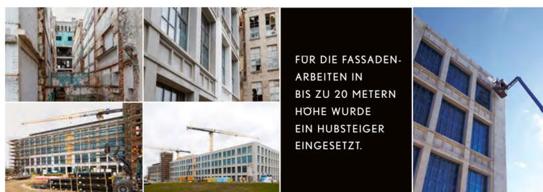
FÜR DIE FASSADEN-ARBEITEN IN BIS ZU 20 METERN HOHE WURDE EIN HUBSTEIGER EINGESETZT.
