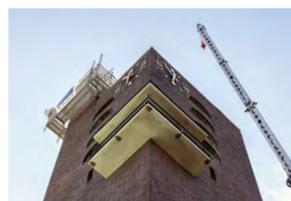
DIE KONSTRUKTION ERLAUBT DACHARBEITEN, OHNE DEN GANZEN TURM EINZURÜSTEN.
