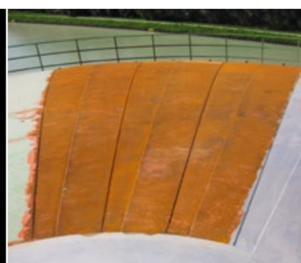
RECHTS: KORROSIONSSCHUTZARBEITEN AN EINEM TANKDACH (VORHER U. NACHHER)
