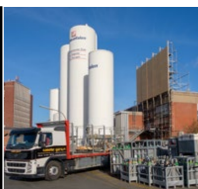
RECHTS: PRÄVENTIVSCHUTZGERÜST FÜR MOGLICHE KAMPFMITTEL-ENTSCHÄRFUNG (2023)
